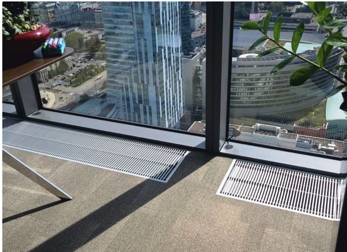
gabinet - system wibroakustyczny
