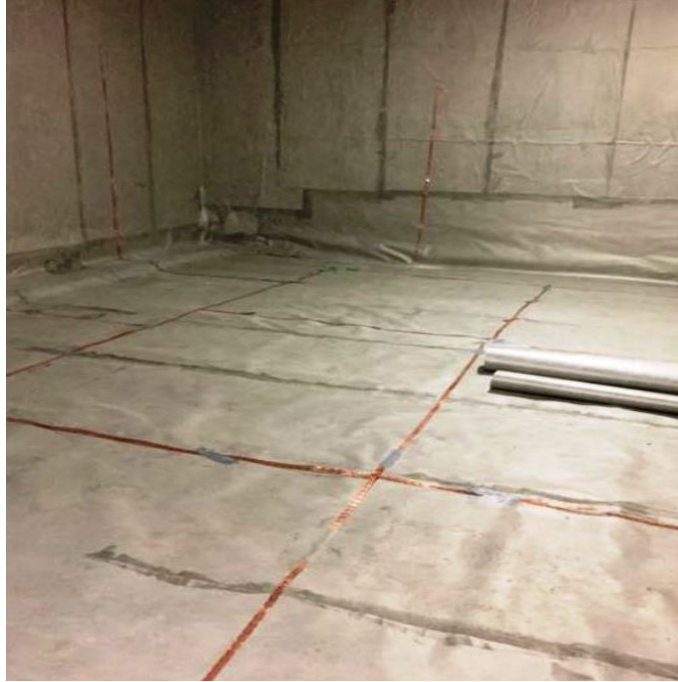
sposób montażu włókniny ekranującej
