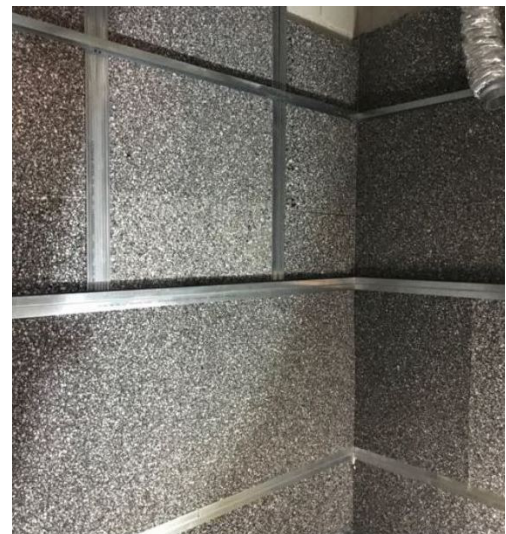
panel akustyczny HDS 50 i sposób jego montażu
