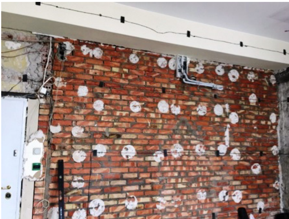
монтаж пьезоизлучателей
